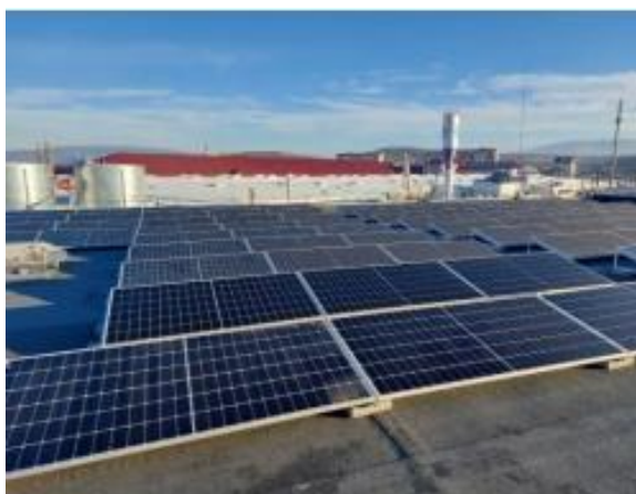
Рисунок 3.8 – Баластна система кріплення для пласких дахів
