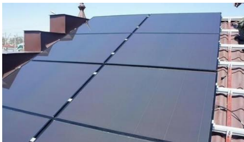
Рисунок 3.7 – Фотоелектрична панель з аморфного кремнію
