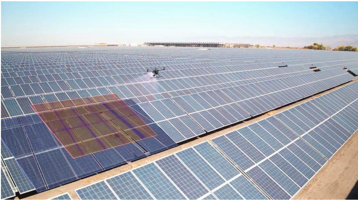
Рисунок 3.12 – Визначення несправностей на ФЕМ за допомогою сучасного дрону
