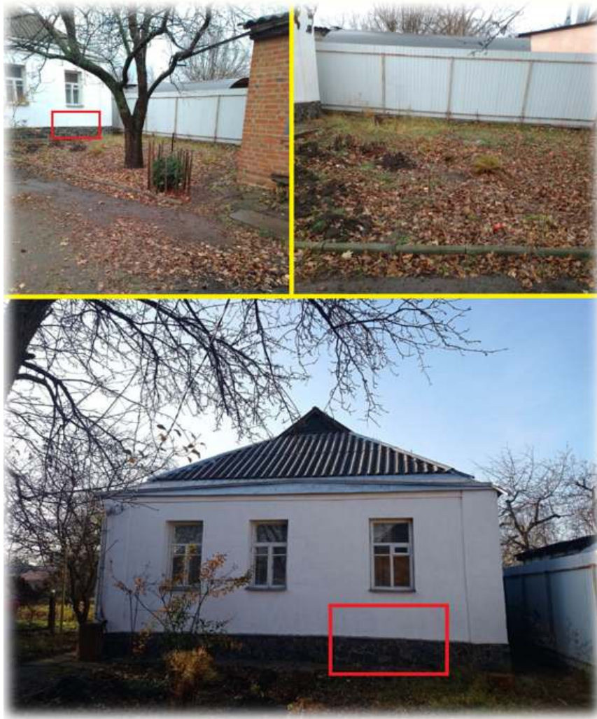
Рисунок 3.2 – Загальний вигляд об'єкту досліджень – типового приватного будинку
