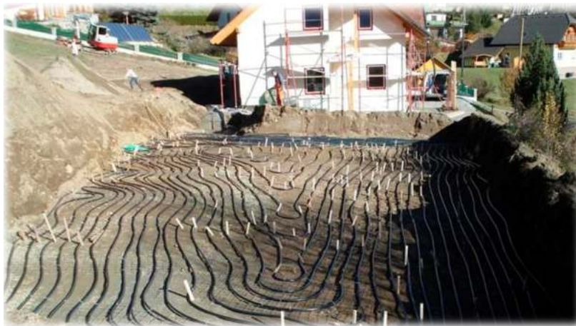
Рисунок 1.3 – Опалення будівлі ґрунтовим тепловим насосом
