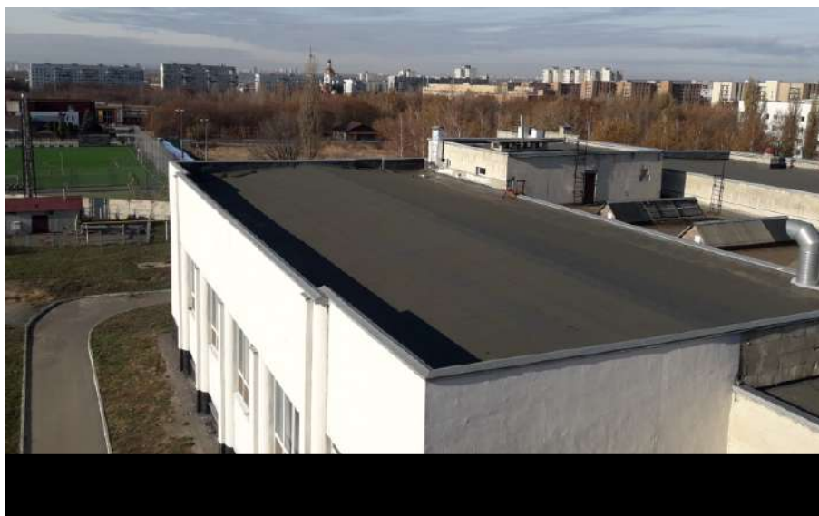
Рисунок 4.7 – Вигляд покрівлі корпусу Б як додаткової площі для встановлення колекторів
