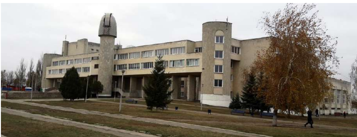
Рисунок 3.2 – Зовнішній вигляд будівлі: при введенні в експлуатацію (зверху) та під час технічного огляду (знизу)
