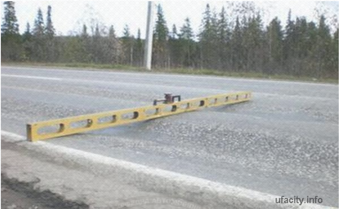
Рисунок 1.6 – Порушення профілю дорожнього покриття
