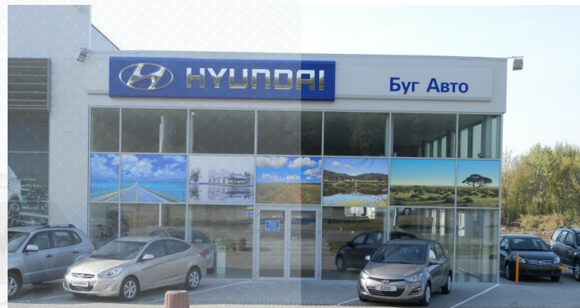
Загальний вигляд будинку СТО
