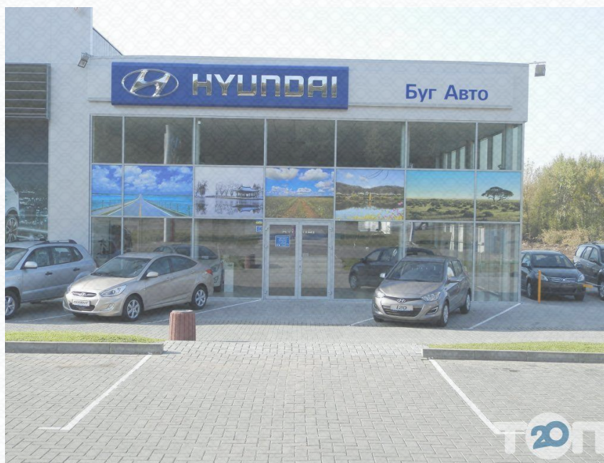
Рисунок 1.2 – Загальний вигляд будинку СТО
