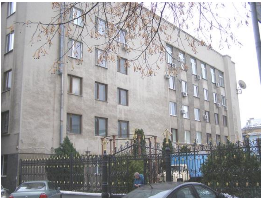
Рисунок 2.3 - Загальний вигляд будівлі з південного боку, фасад по осі «9» в осях «А-Л».
