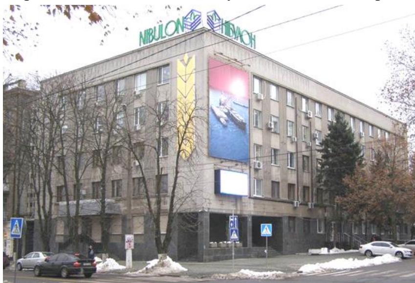
Рисунок 2.1 - Загальний вигляд головних фасадів будівлі по осях «А» та «9», спрямованих, відповідно, в бік вул. Велика Морська та вул. Лягіна.
