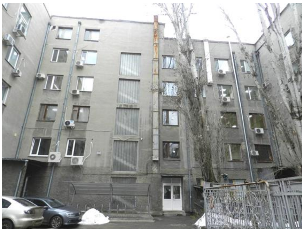
Рисунок 2.5 - Загальний вигляд будівлі з боку внутрішнього дворика, по осі «Г» в осях «7-3».
