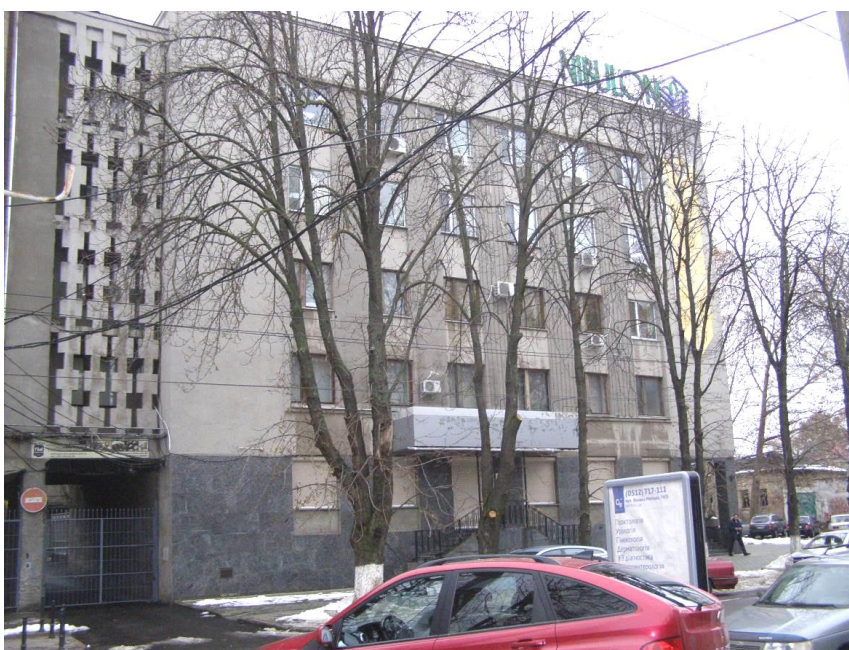
Рисунок 2.2 - Загальний вигляд об'єкта обстеження з північного боку, вид з вул. Велика Морська (фасад по осі «А»). Проїзд у внутрішній двір.
