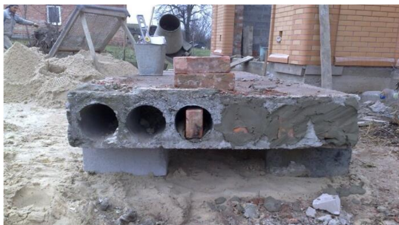
Рисунок 4.5 – Закладання пустот в торці плити перекриття
