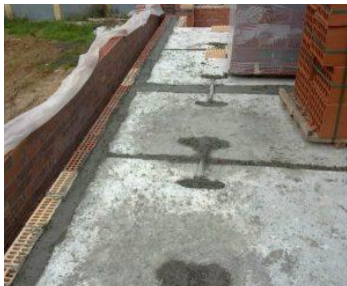
Рисунок 4.7 – Закладання швів перекриття
