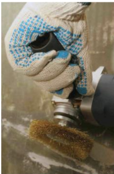
Рисунок 4.1 – Усунення відшарувань на укосах за допомогою електрошліфувальної машини
