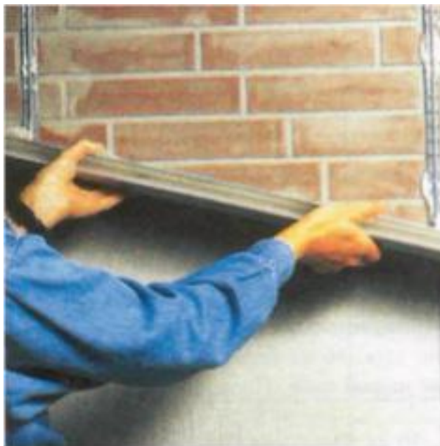
Рисунок 4.2 – Розрівнювання правилом нанесеної штукатурної суміші
