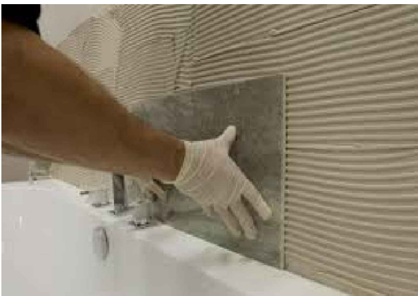
Укладання маячних плиток
