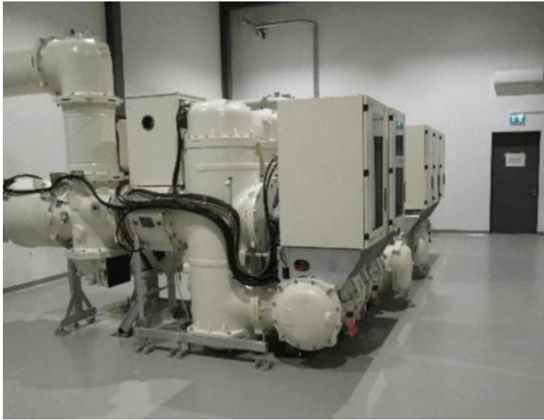
Рисунок 3.1 – GIS-підстанція 145 кВ з g 3 -технологією (АХРО, Швейцарія, 2017)
