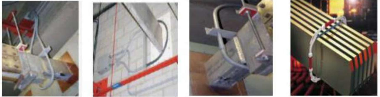
Рисунок 3.4 – Конструкція та монтаж вимірювальної петлі для ВОП типу NXCT-F3 (а,б) компанії NxtPhase, типу LKCO-60 (в) компанії DynAmp та FOCS (г) компанії ABB на потужних технологічних шино проводах.
