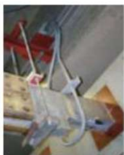
Рисунок 3.4 – Конструкція та монтаж вимірювальної петлі для ВОП типу NXCT-F3 (а,б) компанії NxtPhase, типу LKCO-60 (в) компанії DynAmp та FOCS (г) компанії ABB на потужних технологічних шино проводах.
