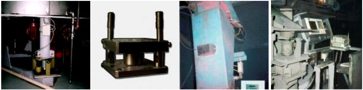
Рисунок 3.9 – Монтаж тензодатчика Scaime під силосом
