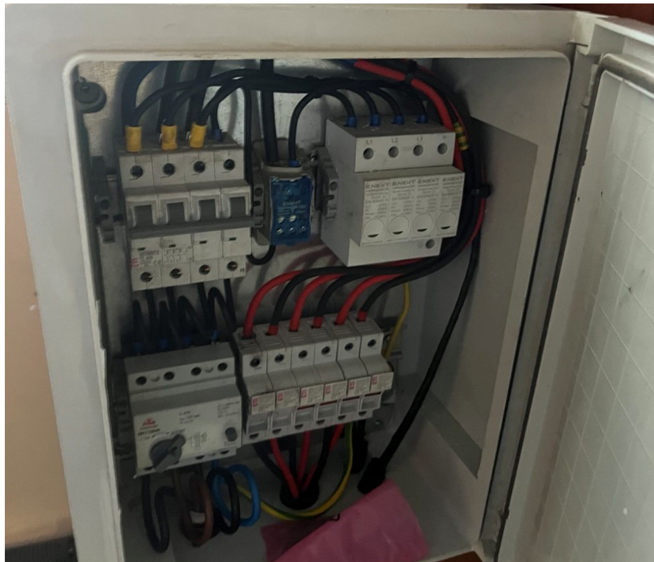
Рисунок 4.6 – Захисна шафа розподільчих кіл постійного та змінного струму
