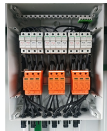
Рисунок 4.8 – Щит захисту AC/DC
