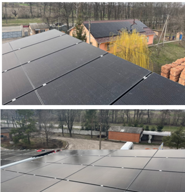
Рисунок 6.6 – Встановлення фотоелектричних модулів типу JKM570N-72HL4
