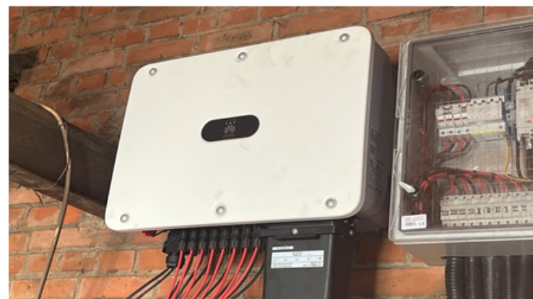
Рисунок 6.8 – Підключення інверторів Huawei SUN2000-50KTL-M3 та шафа керування
