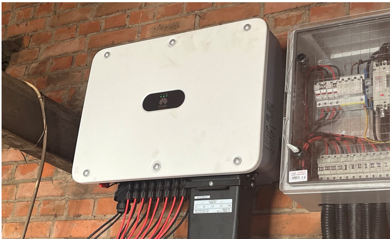
Рисунок 4.7 – Підключення інверторів Huawei SUN2000-50KTL-M3
