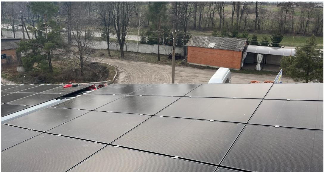
Рисунок 4.5 – Встановлення фотоелектричних модулів типу JKM570N-72HL4 (компанії Jinko Solar)
