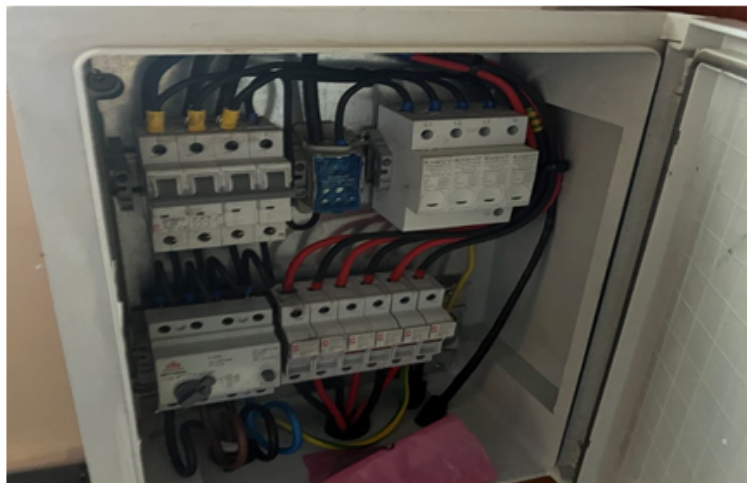
Рисунок 6.7 – Захисна шафа розподільчих кіл постійного та змінного струму
