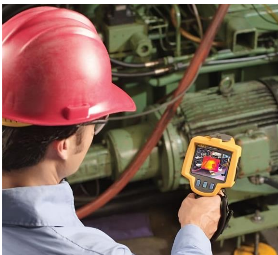
Рисунок 9.1 – Визначення теплового випромінювання поверхні обладнання
