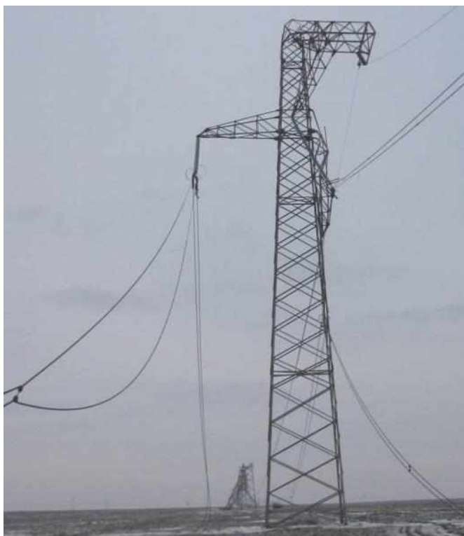
Рисунок 9.5 – Проміжна опора з обривом проводів 330 кВ
