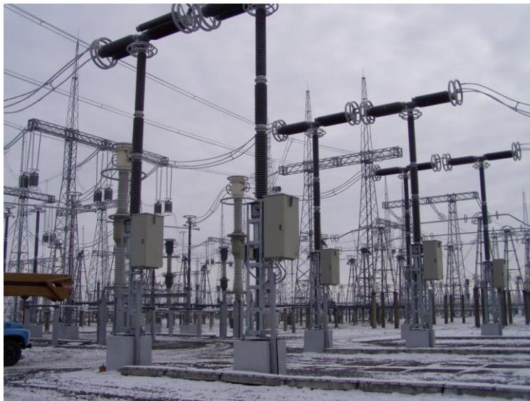
Рисунок 9.6 – Елегазовий вимикач на Вінницькій ПС 750 кВ
