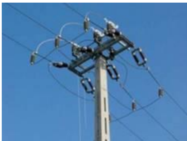
Рисунок 9.3 – Гасники галопування проводів і тросів
