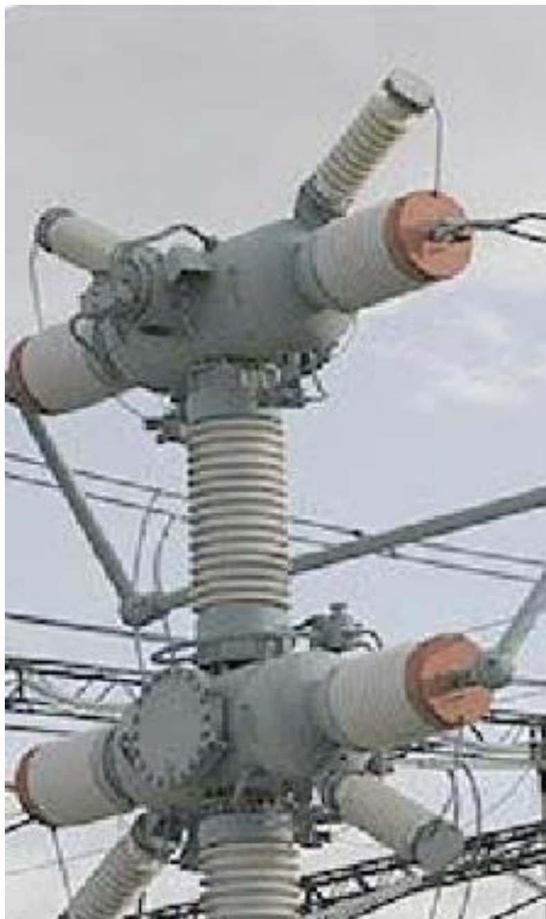
Рисунок 1 – Високовольтний повітряний вимикач
