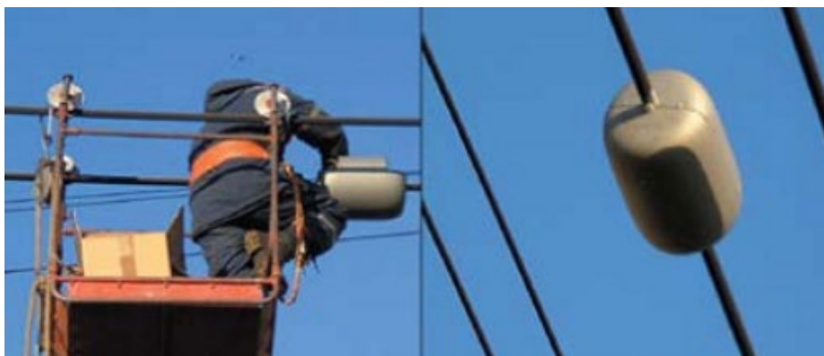
Рисунок 9.10 – Монтаж вимірювального блока на проводах ЛЕП
