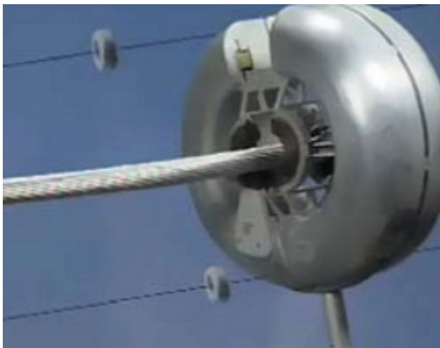
Рисунок 9.11 - Монтаж вимірювача Donut на проводі ЛЕП
