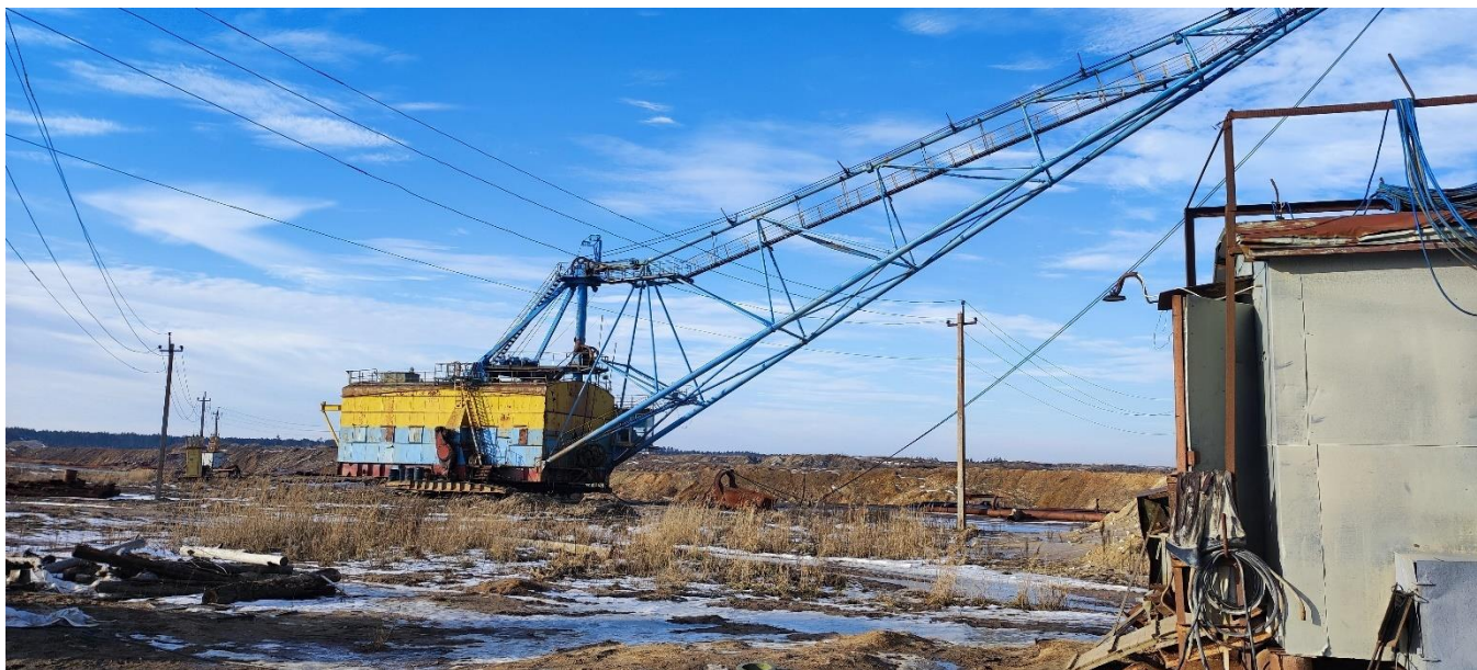
Рисунок 1.1 – Зовнішній вигляд Екскаватора ЕШ 10/70
