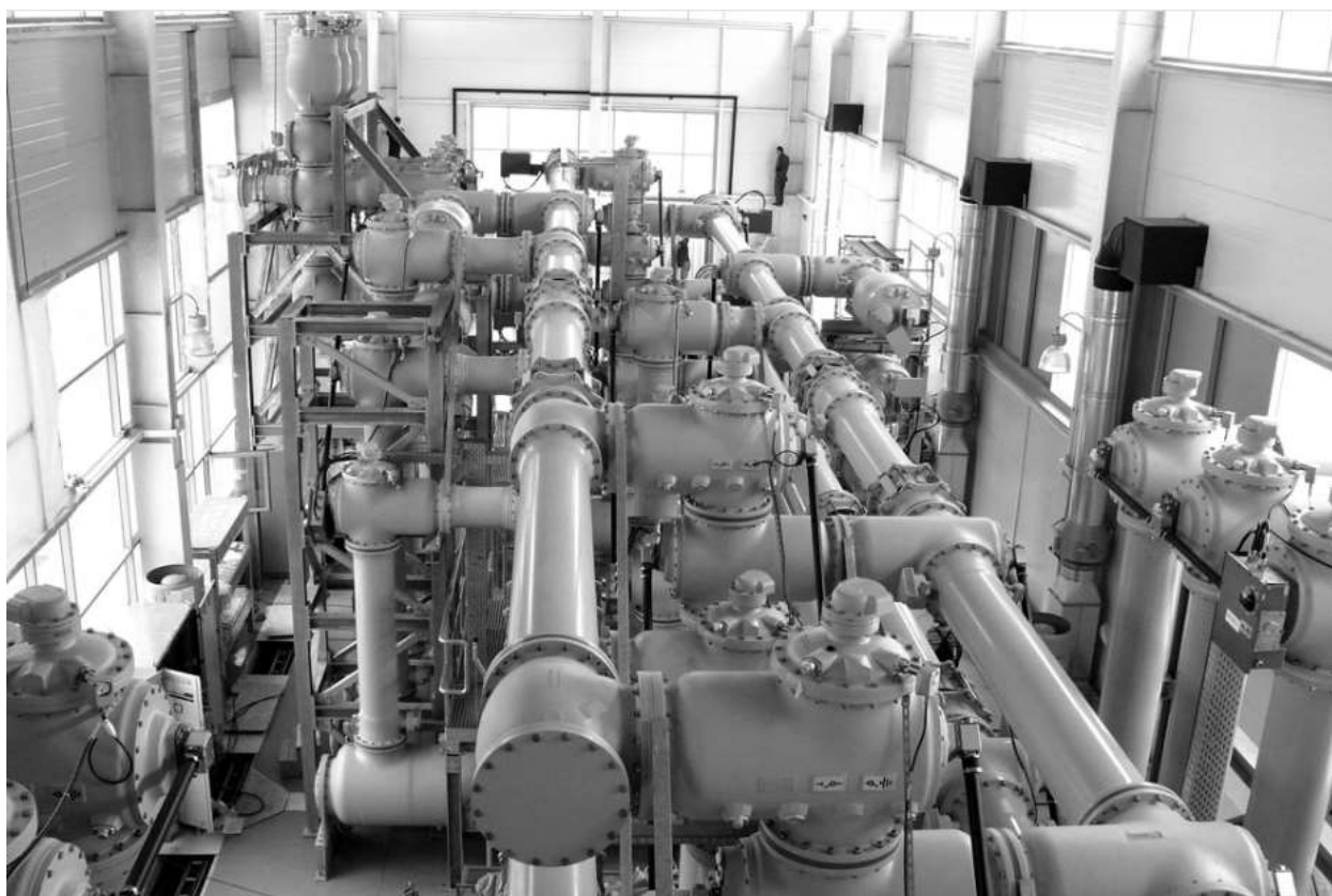
Рисунок 3.16 - КРУЕ ELK-3 330кВ (ABB), Дністровська ГАЕС 2010р.
