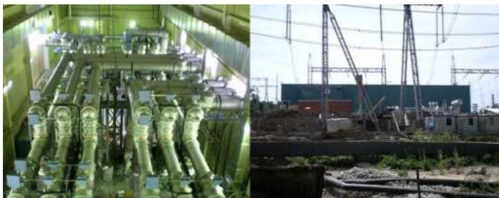
Рисунок 3.11 - КРУЭ 330кВ (ABB)
