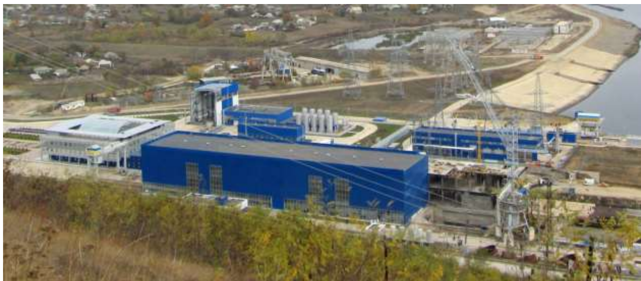
Рисунок 3.14 - Вид на Дністровську ГАЕС, КРУЕ 330кВ
