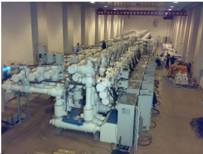
Рисунок 3.10 - КРУЕ - 220кВ, 12+10 комірок вид на КРУЕ
