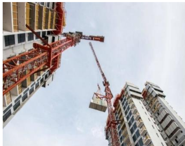
Рисунок 5 – Блочне будівництво в Сингапурі (ЖК Clement Canopy)
