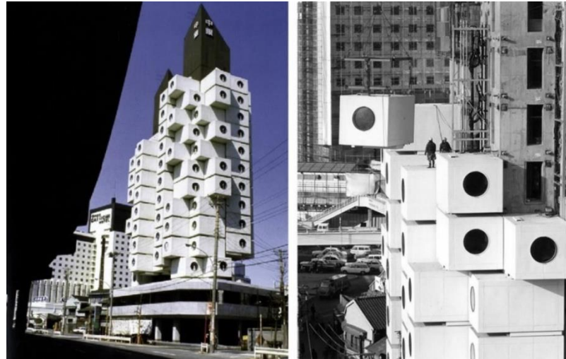
Рисунок 3 – Вежа Накагін, побудована та в процесі монтажу «капсул», Японія
