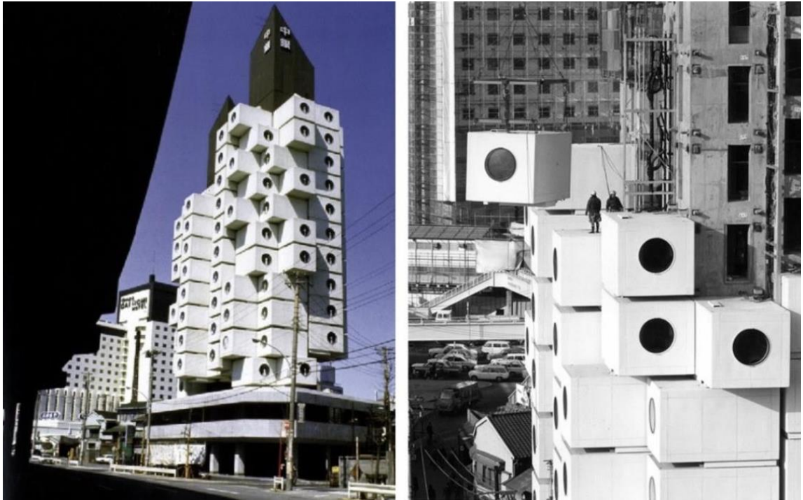
Рисунок 1.3 – Вежа Накагін, побудована та в процесі монтажу «капсул», Токіо, Японія
