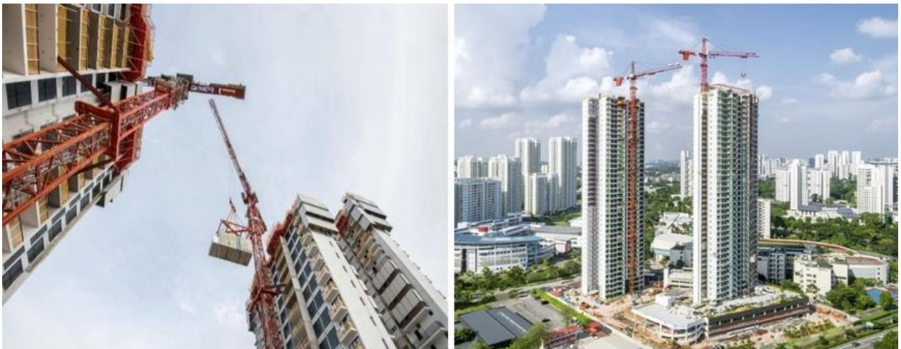
Рисунок 1.7 – Блочне будівництво в Сінгапурі (ЖК Clement Canopy)
