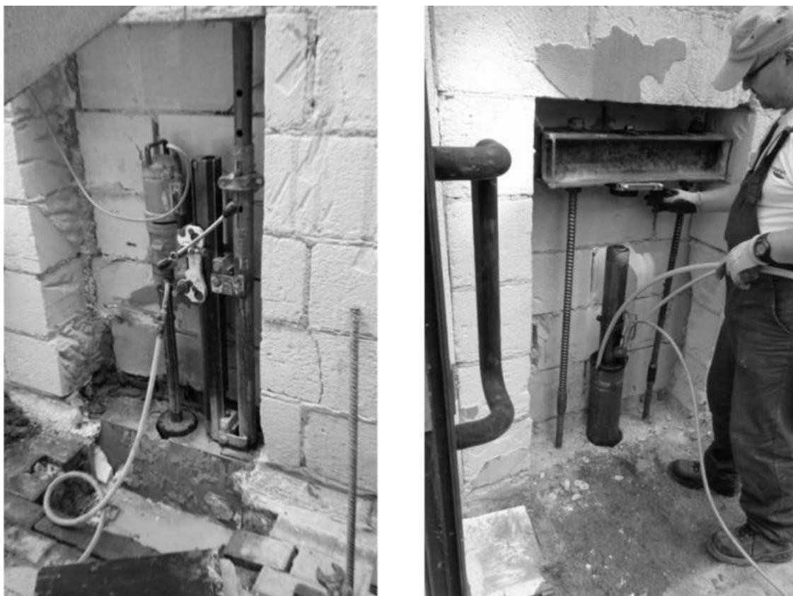
Рис. 1.8. Процес вдавлювання мікропалі (фото) [40]
