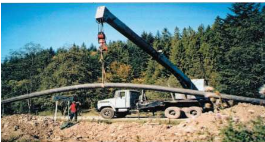
Рис. 2.37 – Укладання газопроводу з використанням техніки
