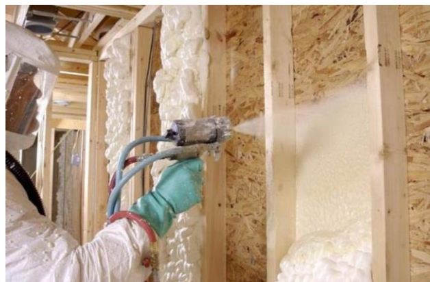
Рисунок 9 – Нанесення пінополіуретану на огороджуючи конструкцію
