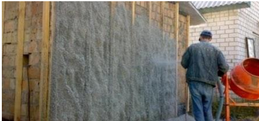
Рисунок 11 – Целюлозний варіант утеплювача у вертикальній площині
