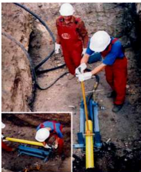
Рис. 3.63 – Пневмопробійники: а – ПП-4605А; б – ПП-4603А
