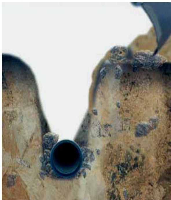
Рис. 3.45 – Укладання ПЕ трубопроводу без піщаного засипання
