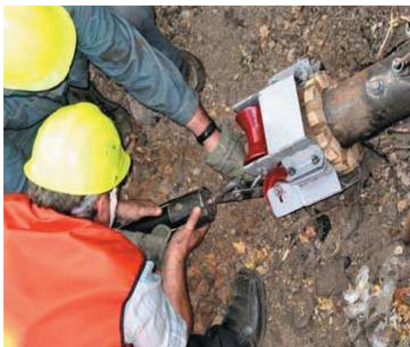
Рис. 3.32 – Прикріплення захисних насадок на сталюий футляр
