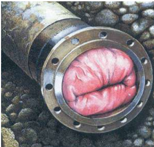
Рис. 3.41 – Поступове вивертання шлангу в газопроводі
