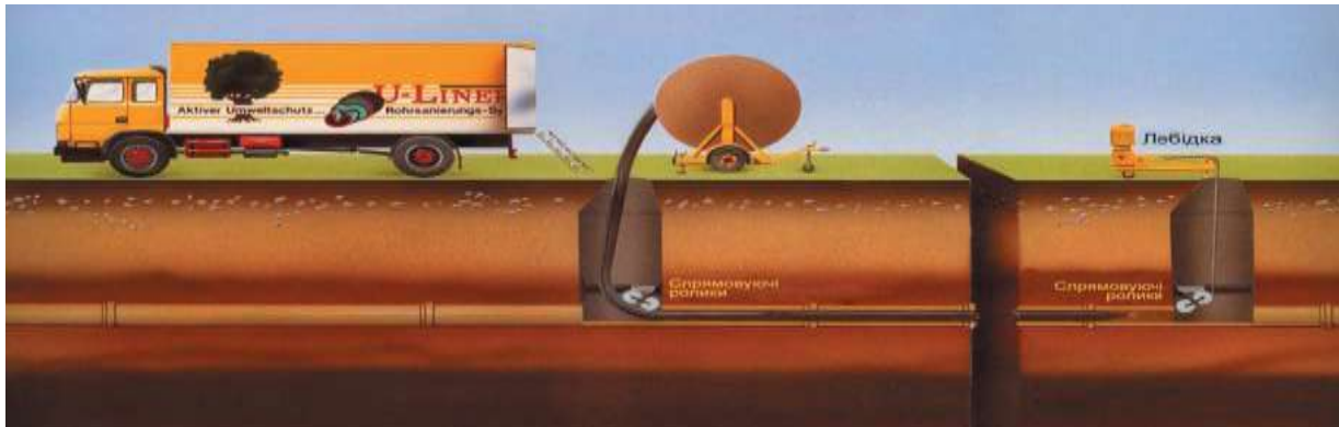
Рис. 3.38 – Втягування «U-ЛАЙНЕРА» в стальну трубу
