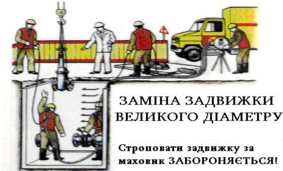
Рис. 3.17 - Газонебезпечні роботи в колодязях
