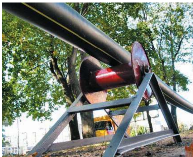
Рис. 3.33 – Укладання ПЕ труби на валики
