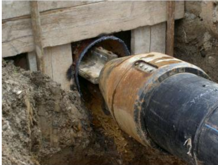
Рисунок 6 – Розширювач для руйнування дефектного металевго трубопроводу
