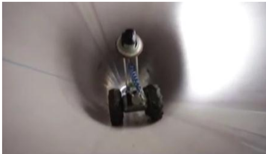
Рисунок 4 – Контроль внутрішньої порожнини трубопроводу самохідною відеокамерою
