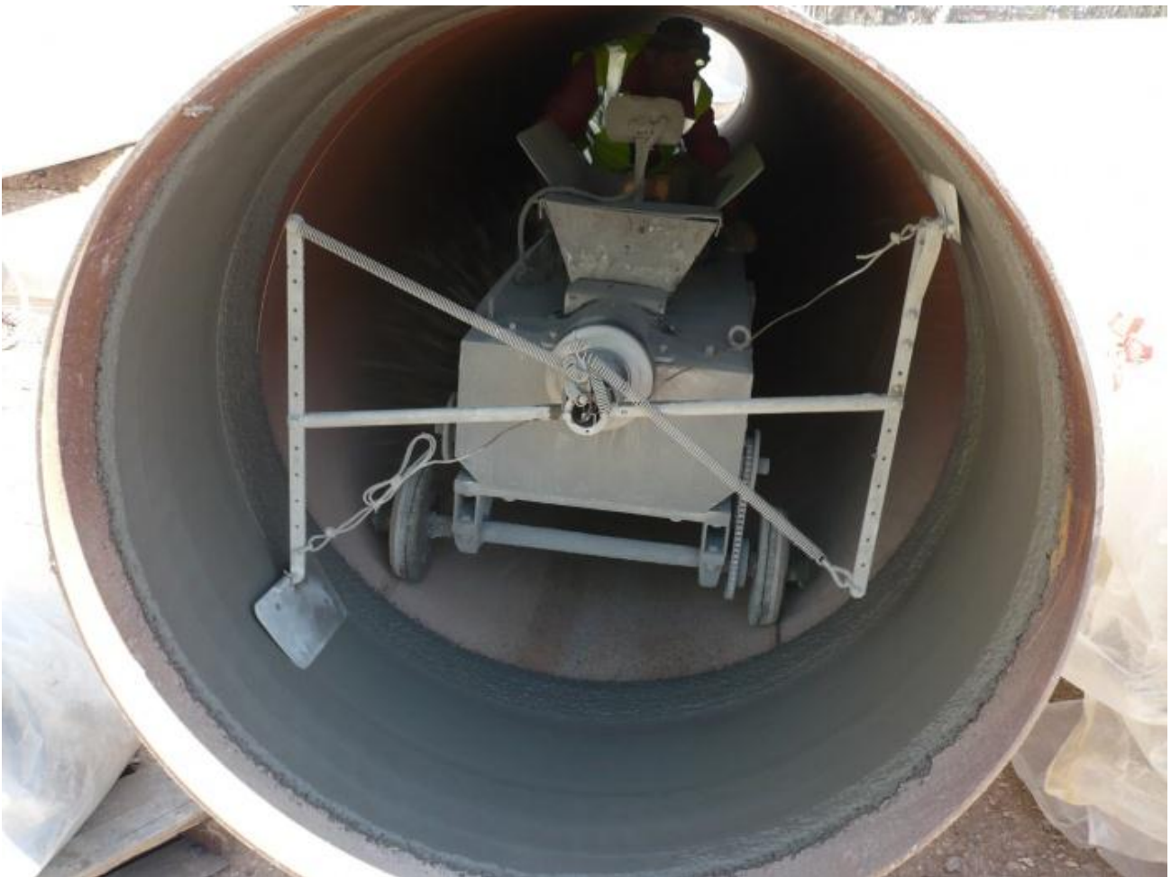
Рисунок 12 – Нанесення цементно-піщаного покриття на внутрішню поверхню дефектного сталювого трубопроводу облицювальним агрегатом
