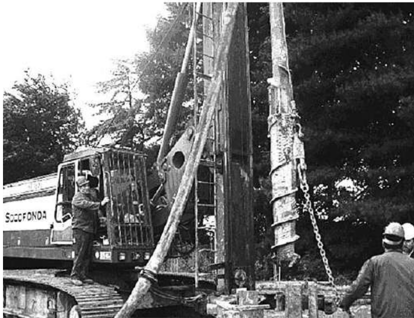
Рисунок 1.21 – Загальний вигляд установки для виготовлення палі за технологією «Омега»
