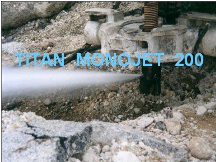
Фотографія сопла струминного монітора
